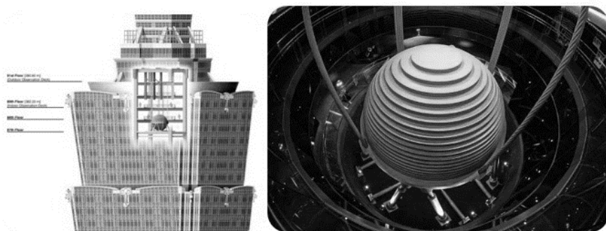
Рис. 14.4. Гаситель колебаний небоскреба Таирей 101
