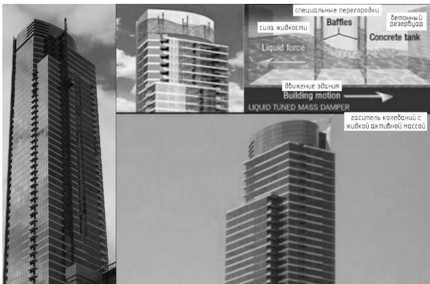
Рис. 14.6. Гаситель колебаний здания One Rincon Hill – South Tower
